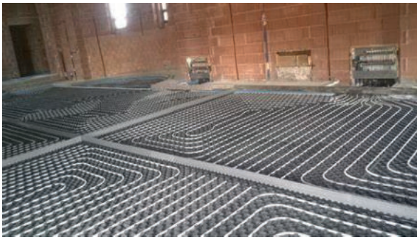
Figura 4: Installazioni di sistemi radianti a pavimento in ambienti di culto
